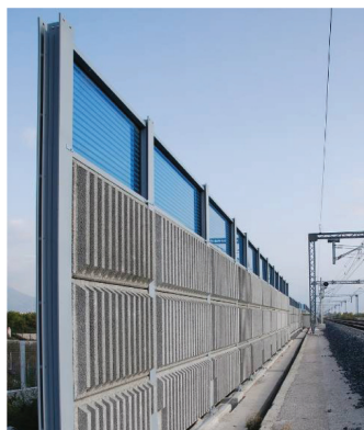
Fig. 1 - Esempio di barriera antirumore utilizzata sulle linee AV/AC di RFI. Example of a noise barrier used on HS/HC lines of RFI.
