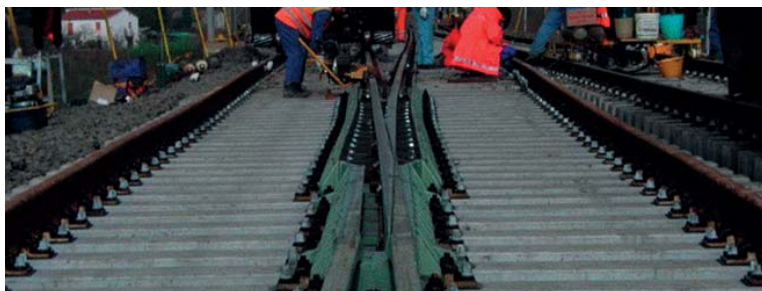
Fig. 73 – Il cuore a punta mobile. Eliminazione dello spazio nocivo e delle controrotaie.
