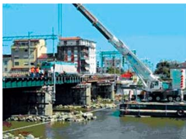
Figg. 39-40 – Varo travata metallica sul fiume Arno per realizzazione terzo binario Pisa C.le – Pisa S. Rossore (maggio/luglio 2004).
