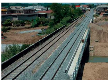
Fig. 23 – Raddoppio del binario sul torrente Staggia.
