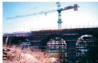
Figg. 7 e 8 – Linea Faentina: ricostruzione viadotto del Palagio.
