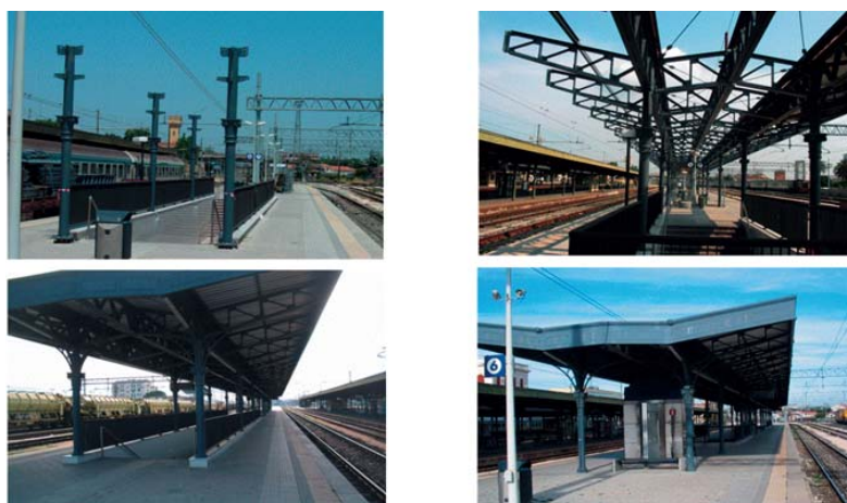
Fig. 46 – Stazione di Livorno: prolungamento sottopasso, nuovo marciapiede alto a servizio 6° e 7° binario con pensilina e ascensore (anno 2003-2004).
