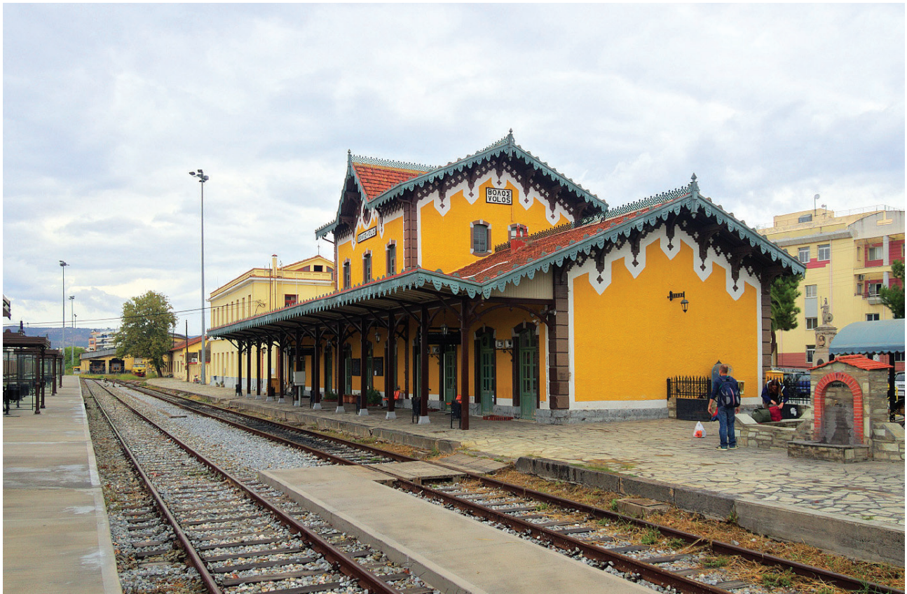
Figura 5 – Stazione di Volos a triplo scartamento: 600, 1000 e 1435 mm.
