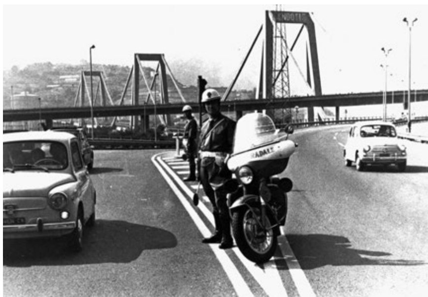
Fig. 3 - Motociclisti della Polizia Stradale sul raccordo con l’Autostrada Genova-Savona: sullo sfondo il viadotto Morandi.
