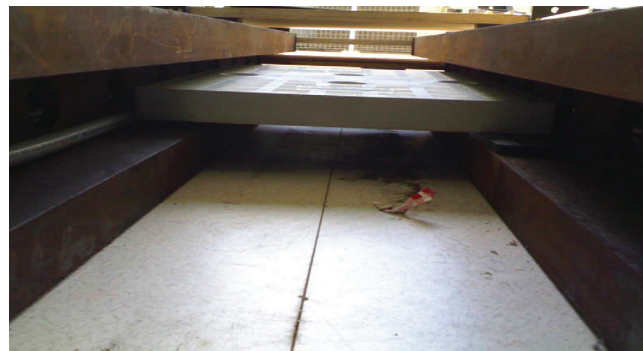
Fig. 10 - BEB posizionata nello spazio libero tra le travi allargate, (270mm).
