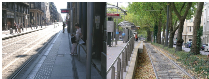
Fig. 2 - Confronto tra l'integrazione urbana delle fermate delle ferrovie leggere con banchine basse ed alte. Comparison of the urban integration of light rail stops with low and high platforms.
