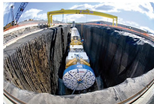
Foto 19 da [12] - TBM aperta da roccia Ø 14 m Niagara Falls.
