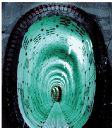
Foto 33 da [11] - Shin-ohmori: Condotta fognaria L=565 m, raggio di curvatura = 20 m.
