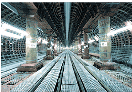
Foto 25 da [11] – Stazione di Osaka Business Park - Sezione 17.44 m di larghezza x 8.85 m di altezza.
