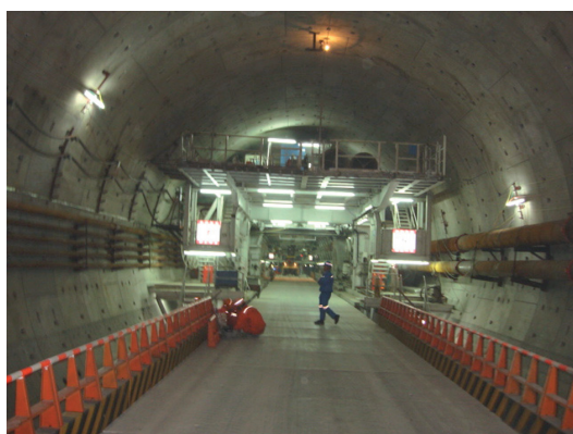
Foto 12 – Interno di una galleria con rivestimento in conci prefabbricati.
