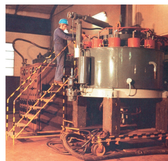
Fig. 7 - Raddrizzatore statico a vapori di mercurio in manutenzione a Bologna.
