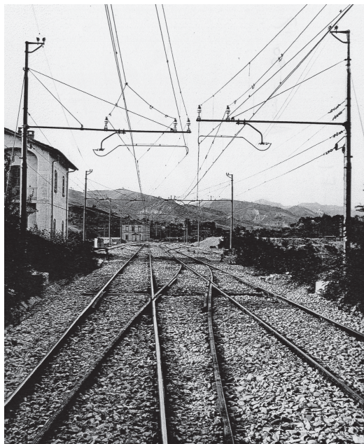
Fig. 10 - Linea di contatto del sistema TE a 3kV cc presso la stazione di Pianoro lato Bologna della linea DD Bologna-Firenze (1939). Particolare del sezionatore a spazio d'aria della comunicazione pari-dispari che garantisce una separazione anche meccanica delle linee.
