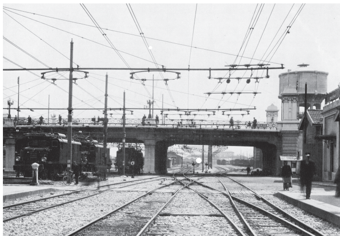
Fig. 4 - Linea di contatto trifase a sospensione trasversale con pali di sostegno tubolari e locomotive E.432 in sosta presso la stazione di Bologna Centrale (1930 circa). (fonte Archivio FS)
