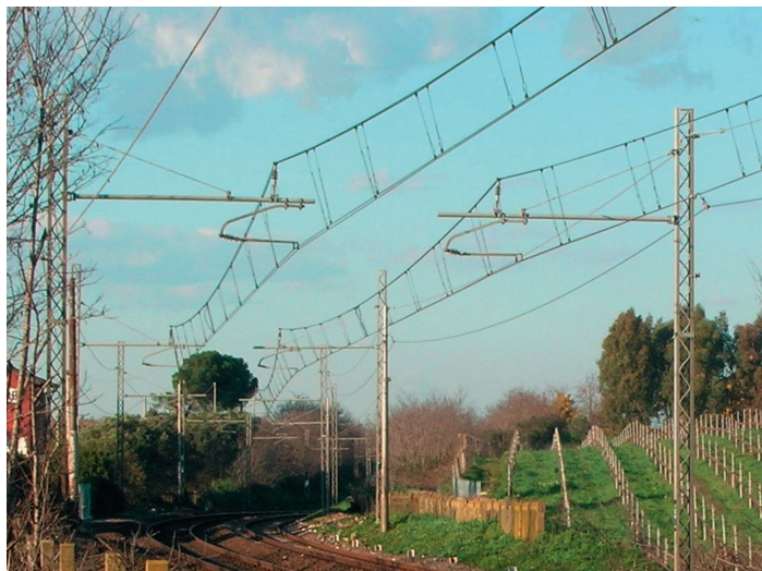
Fig. 15 - Pali di sostegno tipo LS sulla linea Roma-Napoli via Formia (2007).
