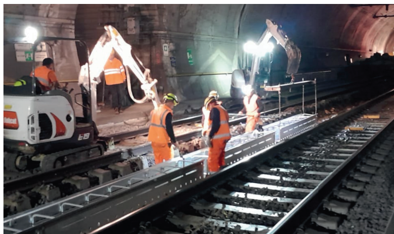
Figura 2 – Lavori in galleria in particolare mediante “water Drain System” sulla linea Pescara-Foggia.
