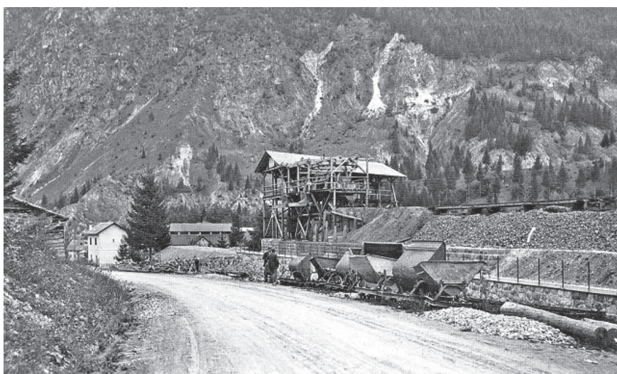
Figura 37 – Vagoncini in attesa del carico calato a valle tramite una teleferica industriale nei pressi della stazione di Rivamonte.
