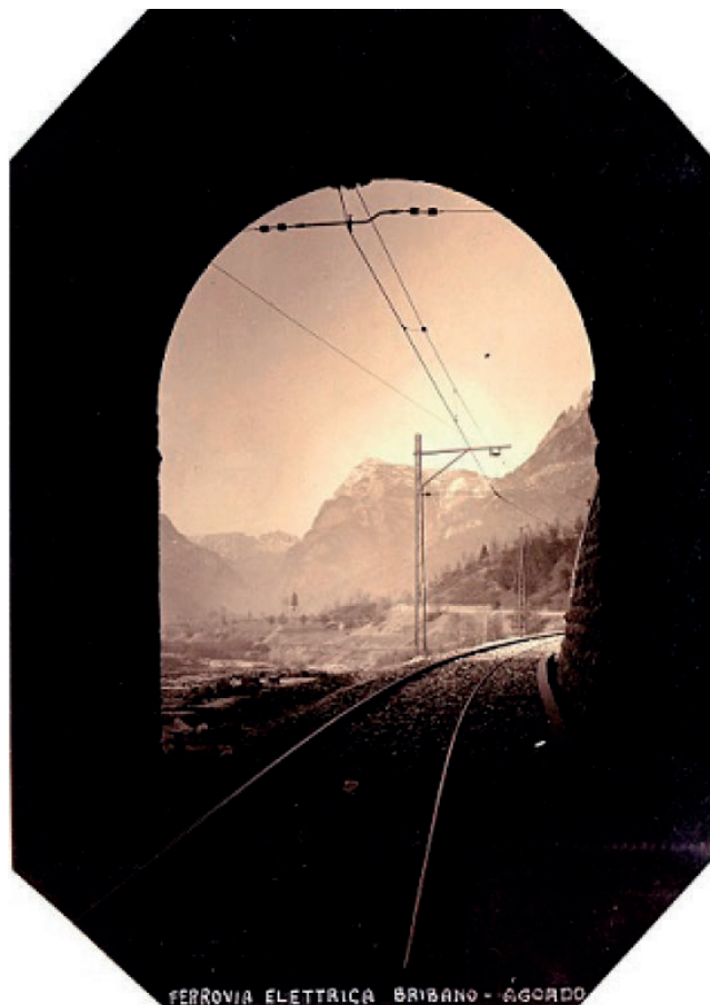
Figura 28 – Linea aerea di contatto in galleria. Figure 28 – Airline contact in the tunnel.
