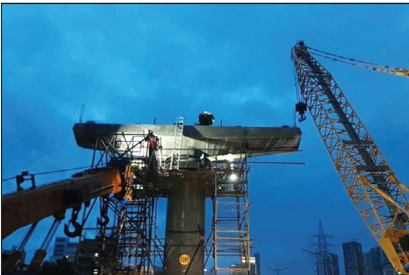
Fig. 9 - Alcuni immagini riprese durante audit ed ispezioni in fase di costruzione. In alto a sinistra: fase di elevazione di una trave ad "U"; a destra: montaggio ferri di armatura di una pila; in basso a sinistra: montaggio pulvino).
