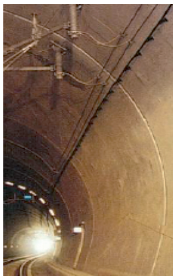
Fig. 4 – Cavo radiante installato sulla volta della galleria.
