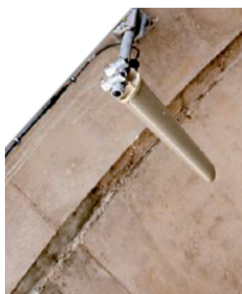
Fig. 5 – Antenna installata sulla volta della galleria.
