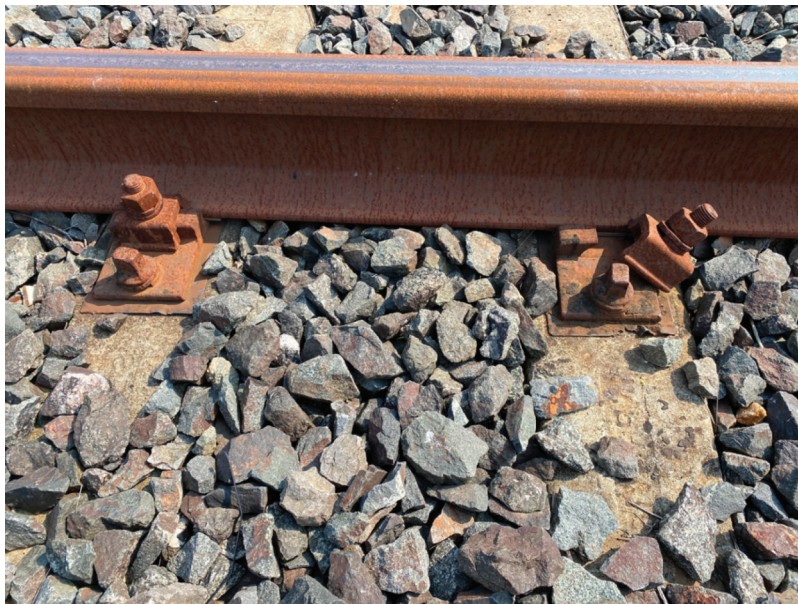
Figura 6 - Esempio di attacco integro e attacco ceduto.
