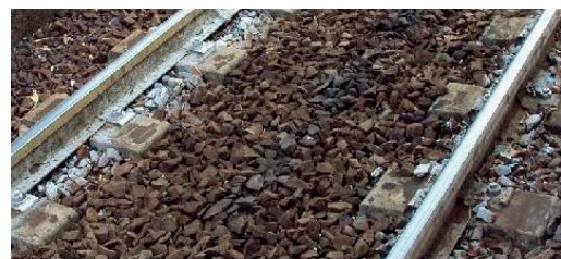
Fig. 4 – Foto di una traversa biblocco in esercizio. Photos of a dual block sleeper in operation.
