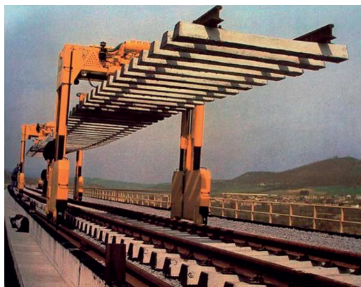
Fig. 9 – Direttissima Roma-Firenze – Viadotto Paglia - Montaggio del binario con portali Donelli. Rome-Florence HS line - Paglia Viaduct - Track mounting with Donelli portals.
