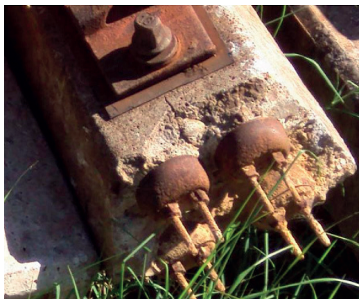
Fig. 8 – Traversa in cap FS – Particolare dell'ancoraggio dei fili. FS sleeper in pre-stressed precompressed concrete – Detail of the anchorage of the wires.
