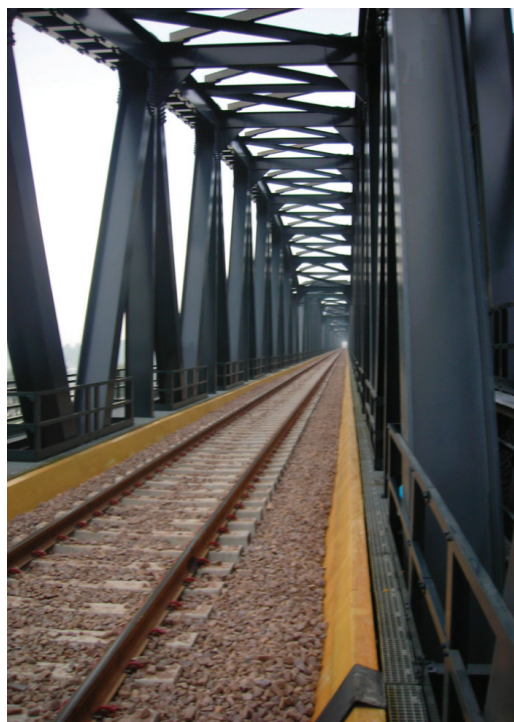
Fig. 4 - Vista dell'armamento su ballast realizzato per il nuovo ponte sul fiume Po ad Ostiglia (MN) sulla linea ferroviaria Bologna-Verona. View of the ballasted-permanent way implemented for the new bridge of Ostiglia (MN) crossing the river Po along the railway line Bologna-Verona.
