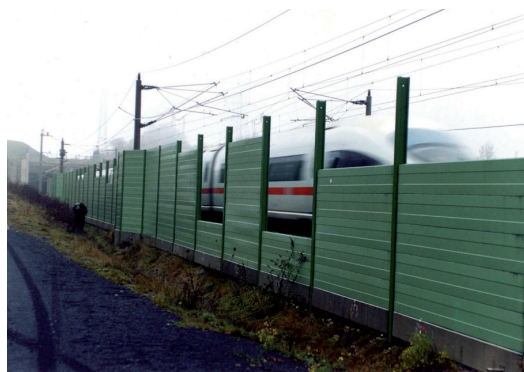
Fig. 1 – Passaggio di un treno ICE accanto ad un tratto danneggiato di barriera antirumore (interasse montanti pari a 5 m) della linea AV Francoforte-Colonia.
