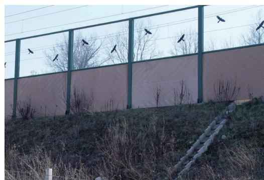
Fig. 6 – Esempio di barriera con pannelli superiori in PMMA.
