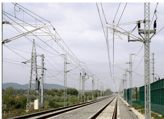
Fig. 4 – Vista della linea di contatto in corrispondenza di un sezionamento TE. View of catenary at an ET section isolator.
