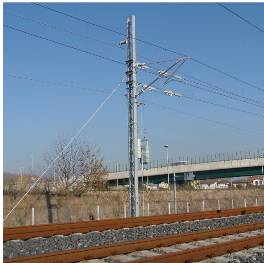
Fig. 25 – Regolazione automatica del tiro per filo di contatto in Cu-Mg. Automatic regulation of tension in Cu-Mg contact wire.
