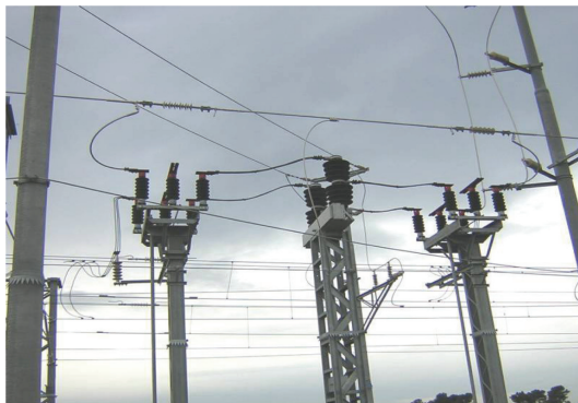
Fig. 22 – Gruppo sezionatore - interruttore SF 6 – sezionatore. Disconnector- SF 6 circuit breaker - disconnector Group.
